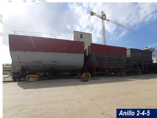
Ilustración 28. Avance proceso construcción Patrullera Oceánica Colombiana (POC)
